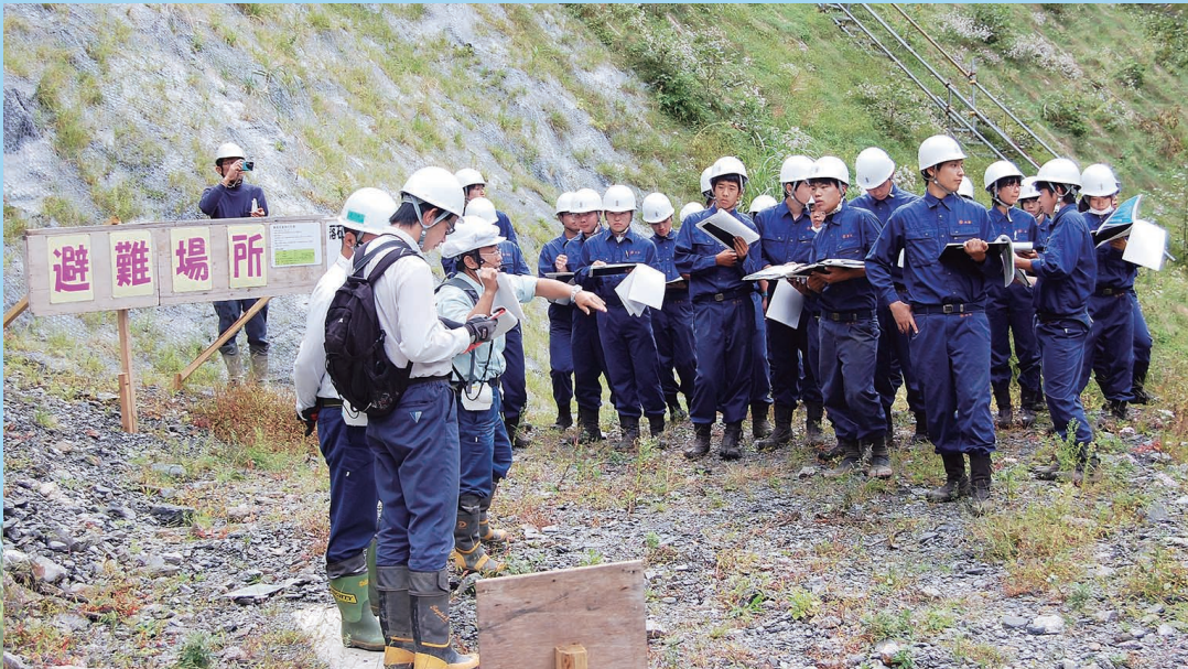
治山工事現場での実習
