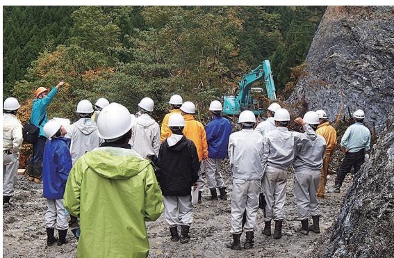
林道工事現場見学
