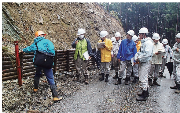
林道工事現場での説明
