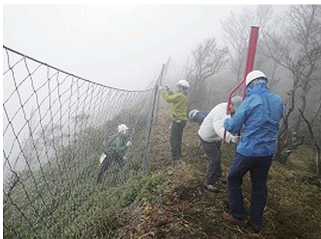
シカ防護柵の補修
