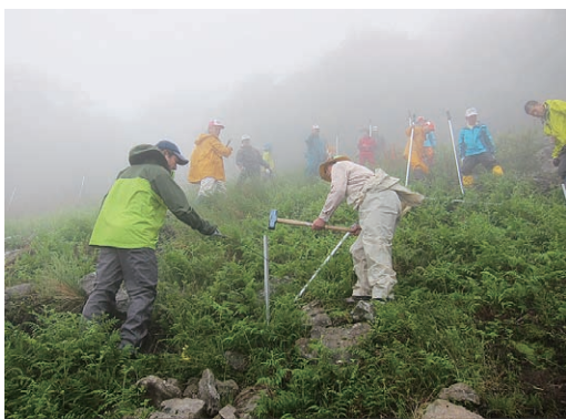
ネット支柱の設置
