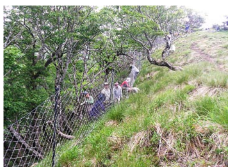
防鹿ネット補修作業
