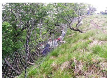
防鹿ネット補修作業
