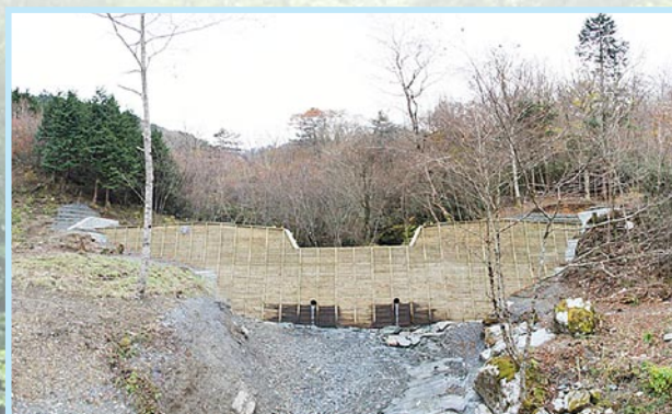
一ノ谷山(82)復旧治山工事【明治建設(有)】
