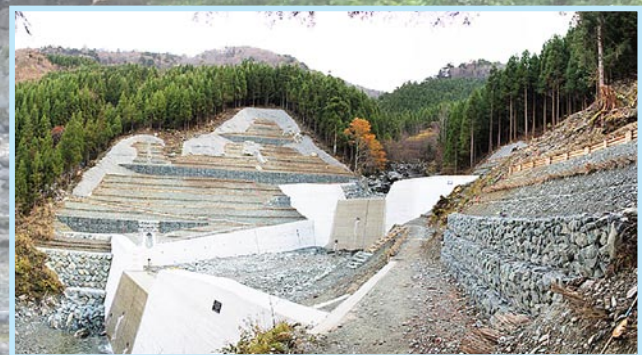
南小川地区アシ谷(右岸)地すべり防止工事(翌債) 【高陽開発(有)】
