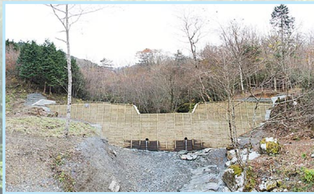
一ノ谷山(82)復旧治山工事【明治建設(有)】
