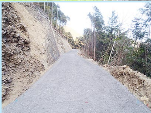
佐川山林業専用道新設工事(明許) 【(株)田邊建設】
