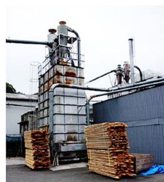
木材乾燥のための熱を供給する木質バイオマスボイラー
