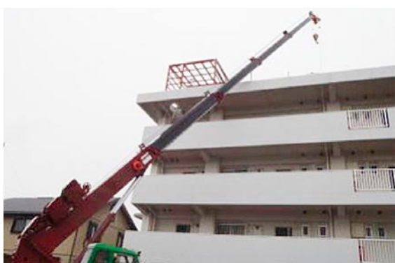
津波避難ビル化の工事中
