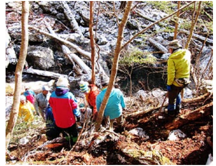
土のうによる階段作り
