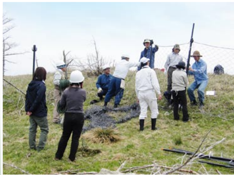
ニホンジカ食害防護柵作設中 (平和丸)
