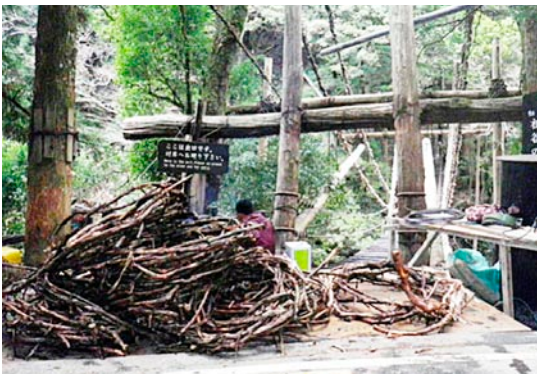
かずら橋架け替え資材の供給(シラクチカズラ)
