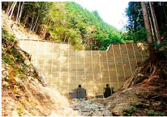
【木材利用】谷止工残存型枠(高知県四万十町)
