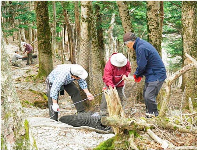
樹木ガード設置作業
