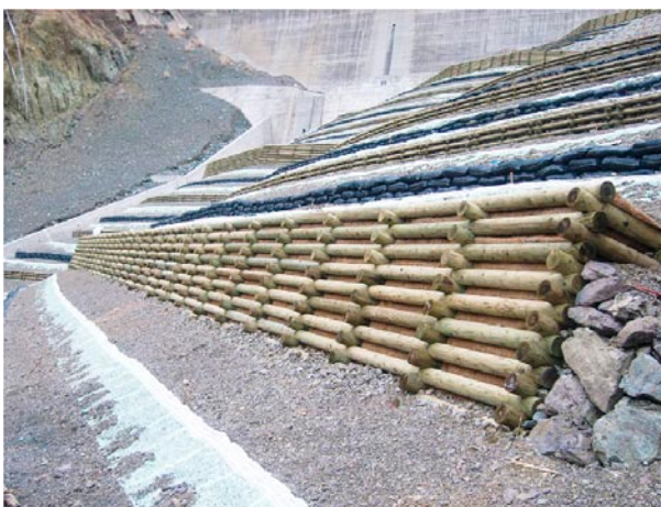
【木材利用事例】山腹崩壊地に施工した丸太土留工（徳島県那賀町）
