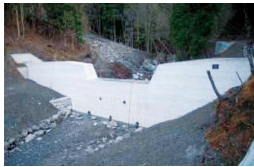
谷止工の施工状況
