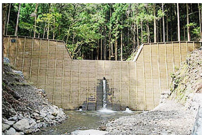
残存型枠を使用した景観に配慮した谷止工(高知県四万十町)
