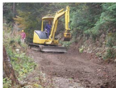
レンタルバックホウによる林道修繕
