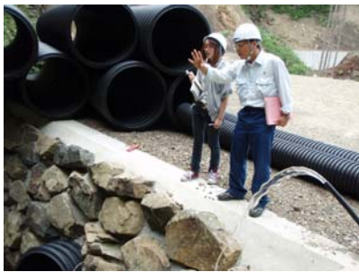
林道新設工事箇所の説明
