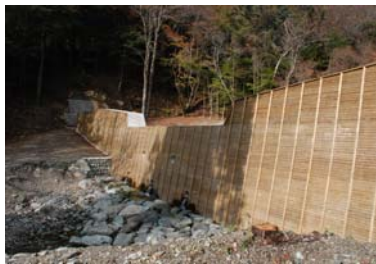
存置型 型枠を使用した治山ダム工
