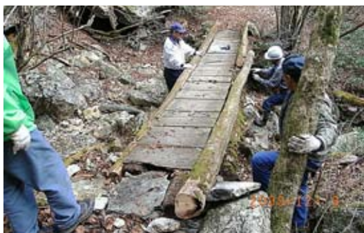
木製橋の修繕
