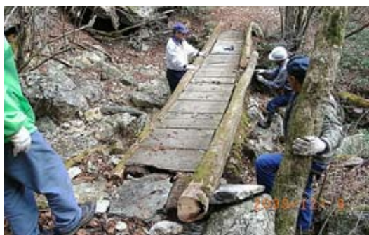
木製橋の修繕
