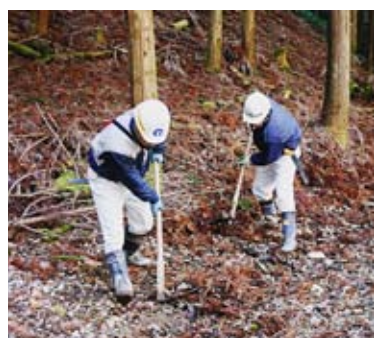
歩道整備の様子
