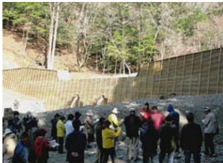
堰堤長 74 m の木製残存型枠ダムを見学
