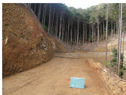
橋ヶ谷林業専用道新設工事（明許）【株生田組】
