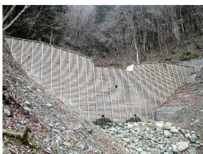
祖谷川地区樫尾（対岸）地すべり防止工事（明許）【有上西組】
