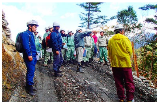
三年生 林業専用道新設工事箇所見学
