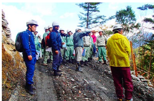
三年生 林業専用道新設工事箇所見学
