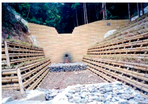
残存型枠治山ダム工
