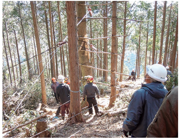
架線集材設備の確認の様子
