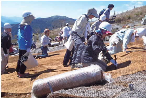
植生回復用マットを設置
