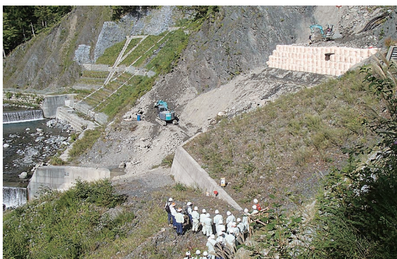
治山工事現場にて(二年生)
