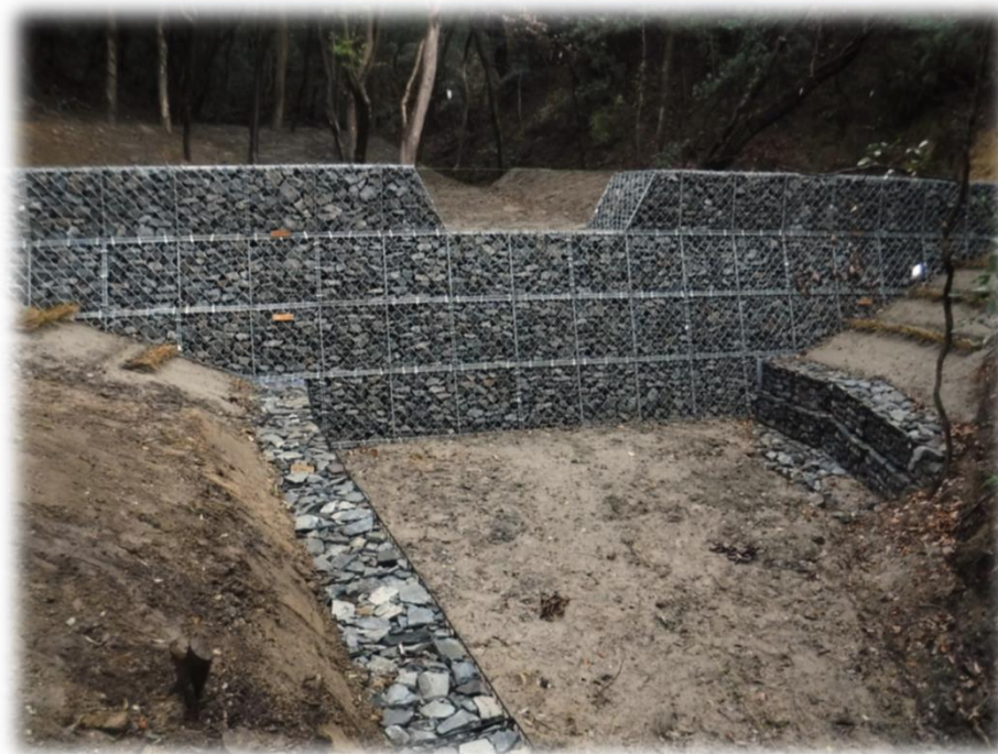
溪流に設置した堰堤(鋼製組立網床固工)
