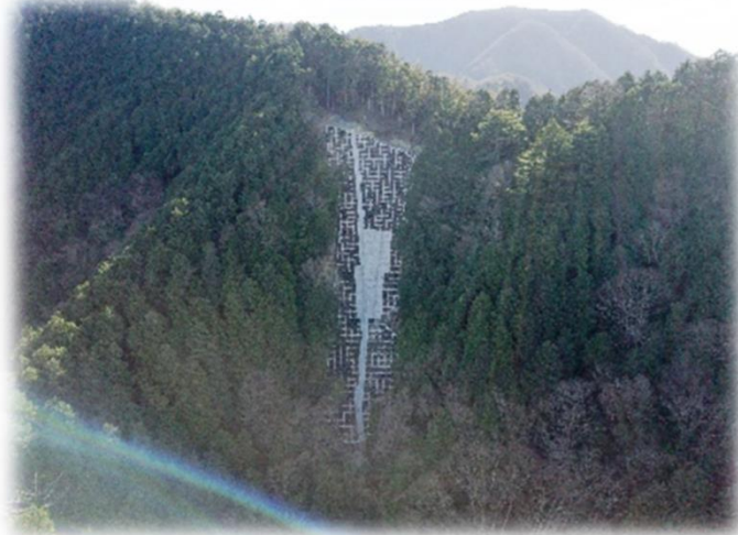
崩壊地を山腹工により復旧 （東かがわ市 中尾国有林）
