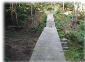
緩和された溪床勾配 (堰堤の左側部分)
