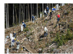
防護柵設置作業
