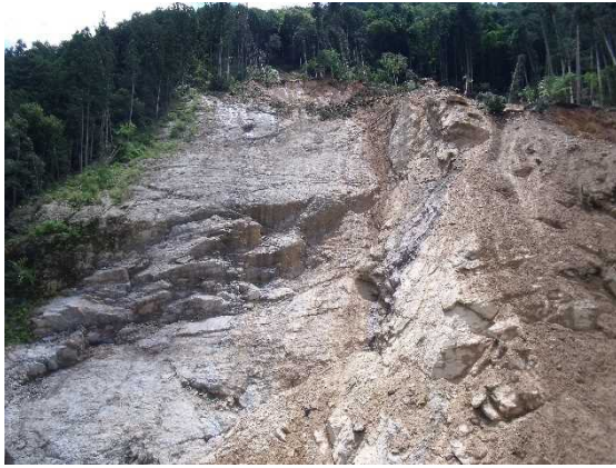
三好市山城町白川地区の被災地
