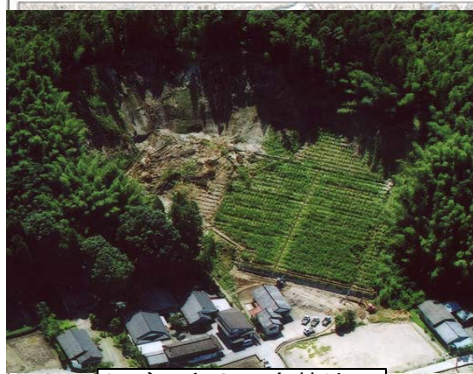
えびの市小田字麓地区 山腹工：簡易法枠工等
