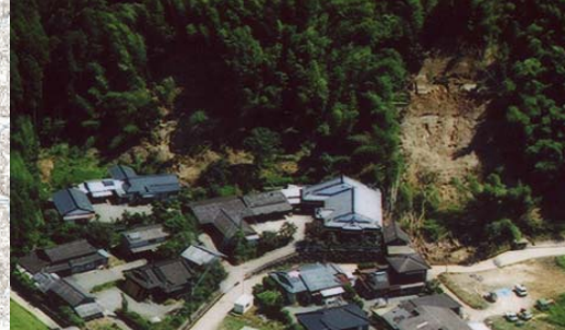
えびの市大明司字脇村地区 山腹工：土留工、法枠工等
