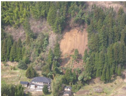
能登半島地震による被害（石川県輪島市）
