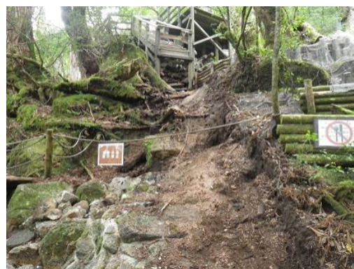
図Ⅱ-28. 解体後
