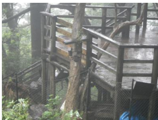
図Ⅱ-29. 南デッキに設置したセンサーカメラ2台
