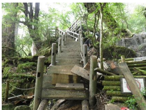
図Ⅱ-27. 解体中の階段
