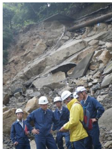
図Ⅳ-11. 湯泊林道災害現場
