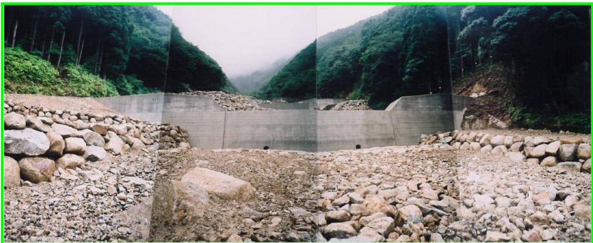
土面川本流(2) 治山工事
