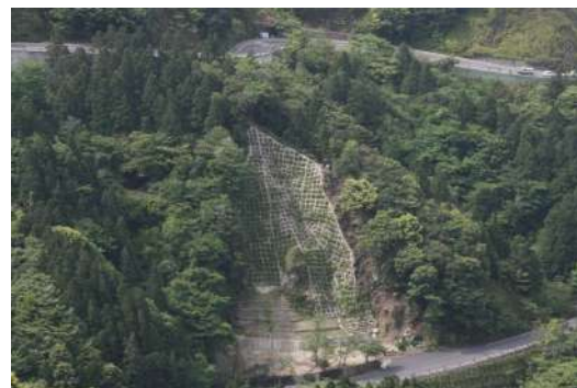
宮之浦岳治山工事
