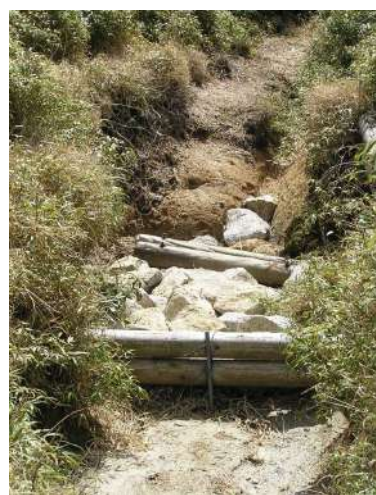
土砂流防箇所への丸太柵工と石礫充填工
