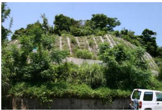
乙崎治山工事
