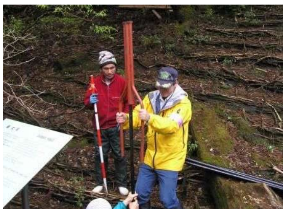
シカ柵の設置状況（杭打ち）
