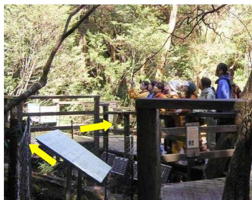
写真撮影に配慮したデッキ前方の低柵（矢印が柵）
