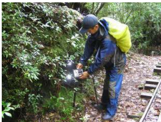
樹名解説板の補修
