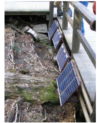
Webカメラソーラーパネルの 増設(両側2枚)
