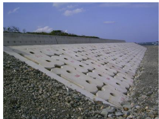
傾斜型護岸工(種子島)
