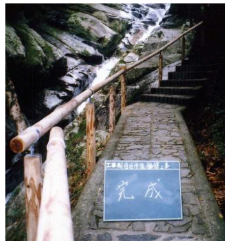
手摺設置(白谷雲水峡)
