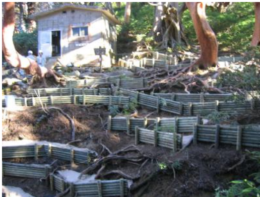
高塚小屋周辺植生回復工事
