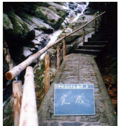
手摺設置(白谷雲水峡)
