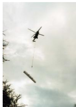
(ヘリ資材運搬) 天忠橋新設工事(荒川地区)
