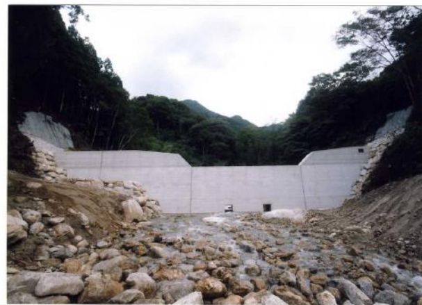
白川治山工事(コンクリート谷止工)
