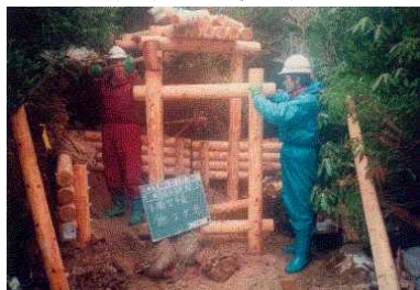
(木橋形歩道施工状況)
