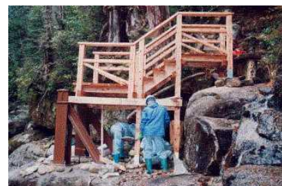
(天柱橋橋脚工事)
