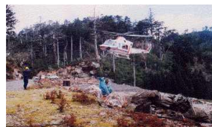
(天柱橋橋脚工事に伴う資材運搬状況)
