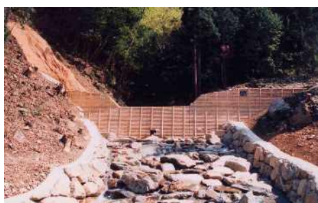
石塚治山工事 (木製型枠谷止工)
