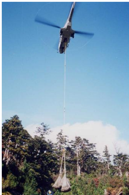
小花之河土砂流入防止工事(資材運搬実施状況)
