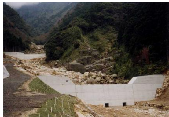
永田地区(土面川谷止工)
