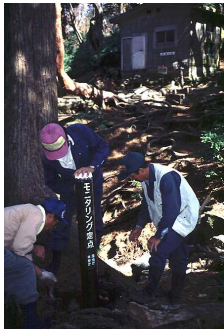
定点杭設置状況
