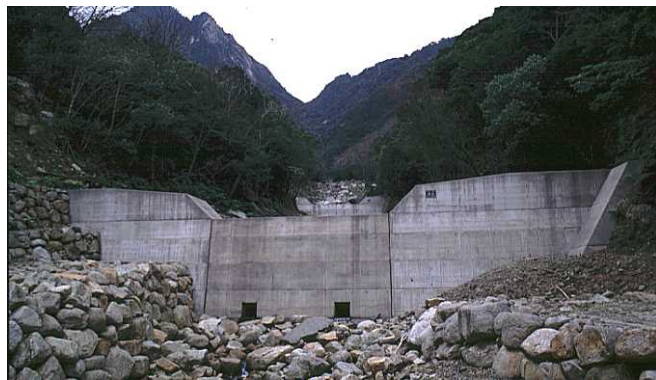
治山ダム設置状況（238林班）
