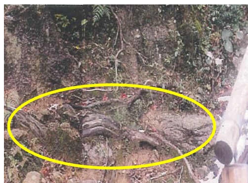
崩壊による折損根の状況
