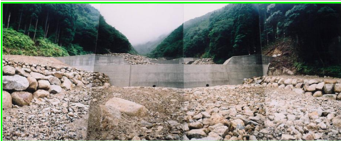
土面川本流(2) 治山工事
